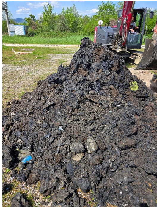
Fotografije 15 i 16: Raskop OŠJ-10
